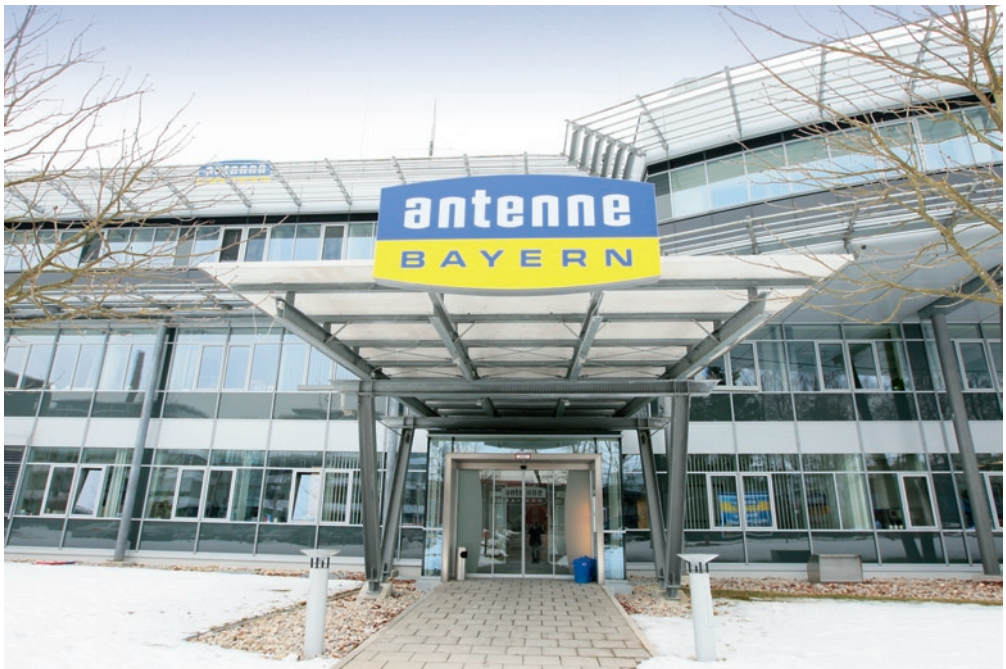
Abb. 1: Die Klimaanlage im neuen Gebäude von Antenne Bayern wurden bei laufendem Betrieb um ein VRF-Klimasystem mit Wärmerückgewinnung erweitert.
