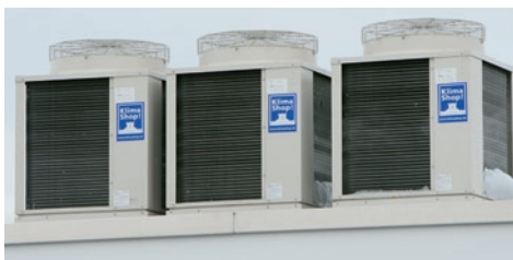
Abb. 2: Drei VRF-Außengeräte wurden auf dem Gebäudedach installiert. Im Endausbau sind 12 Außeneinheiten mit einer thermischen Leistung von insgesamt 510 kW vorgesehen.
