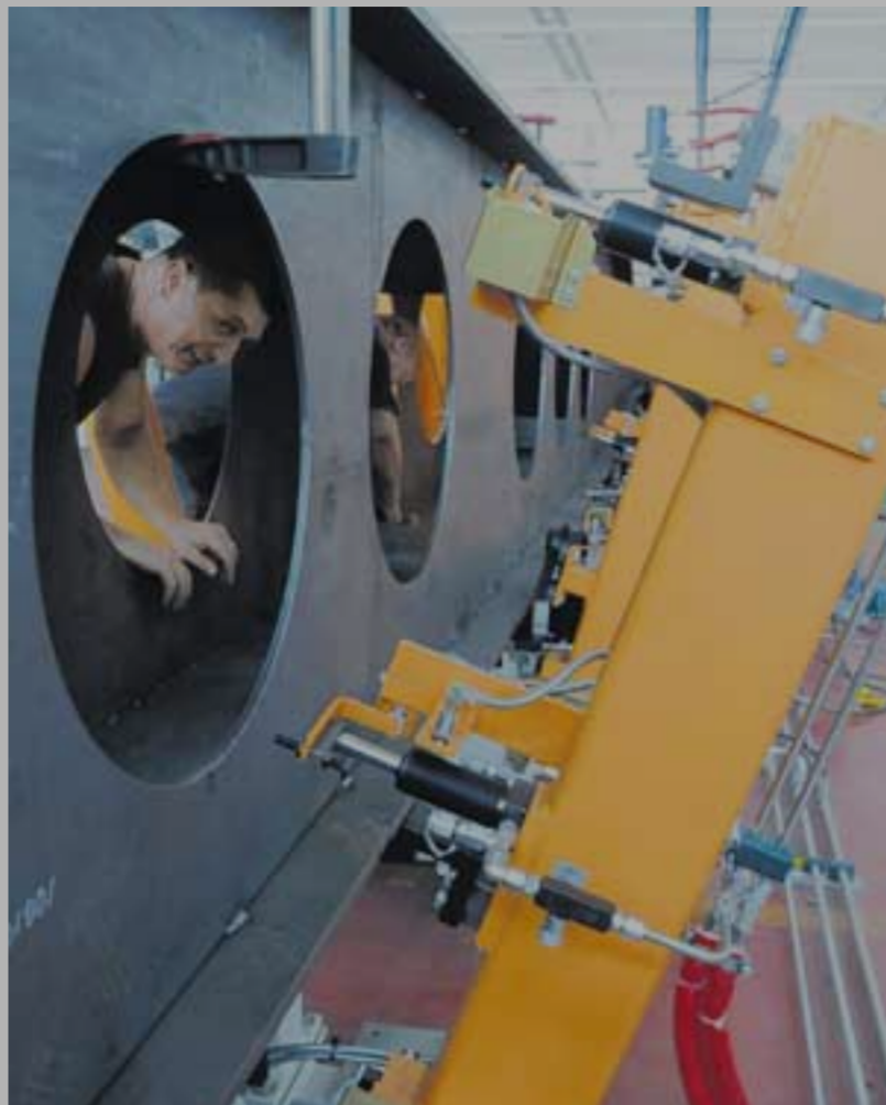
Bei den bis zu 25 Meter langen Bauteilen müssen die Mitarbeiter auf höchste Präzision und perfekte Schweißverbindungen achten. Fotos: Ruth Plössel
